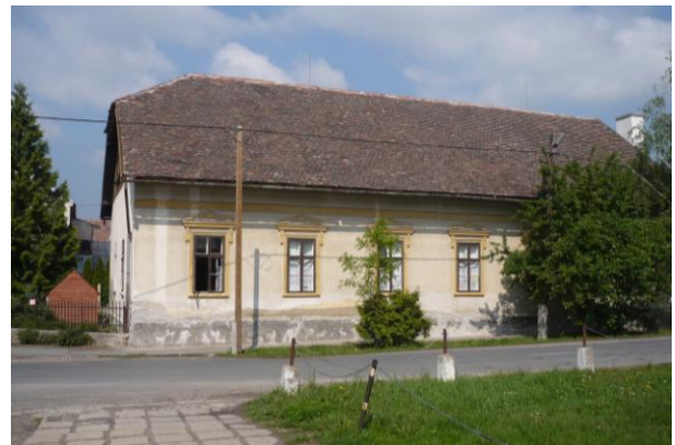
Tetőtér beépítés előtt
